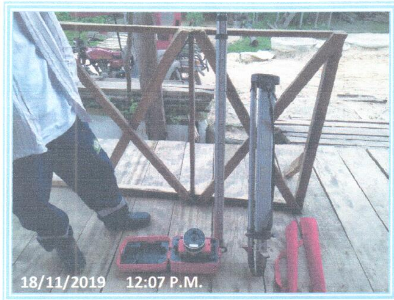
Foto 07: Se observa los accesorios del equipo topográfico usados en la Obra de Glenda Freytas.
