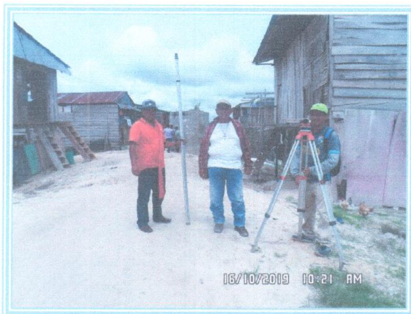
Foto 5: Se aprecia los trabajos de Trazo, Niveles y Replanteo sobre el terreno de la Obra con el personal calificado en presencia del Residente de Obra.
