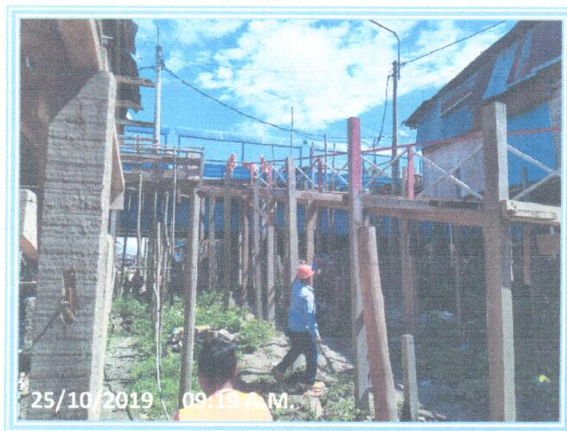
Foto 8: Se aprecia el desmontaje del puente de madera que está ubicado en la Calle Universitaria a cargo de la Junta Vecinal a la altura del puente de Glenda Freytas.
