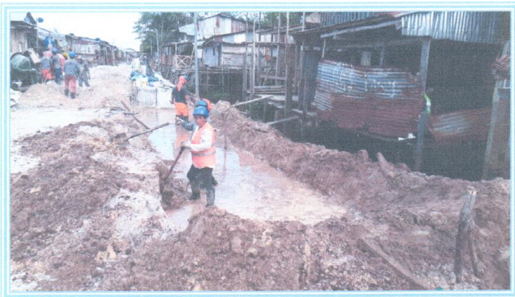
Foto 02: Se observa al personal obrero en los trabajos de corte manual para la colocación del encofrado y Big Bag.
