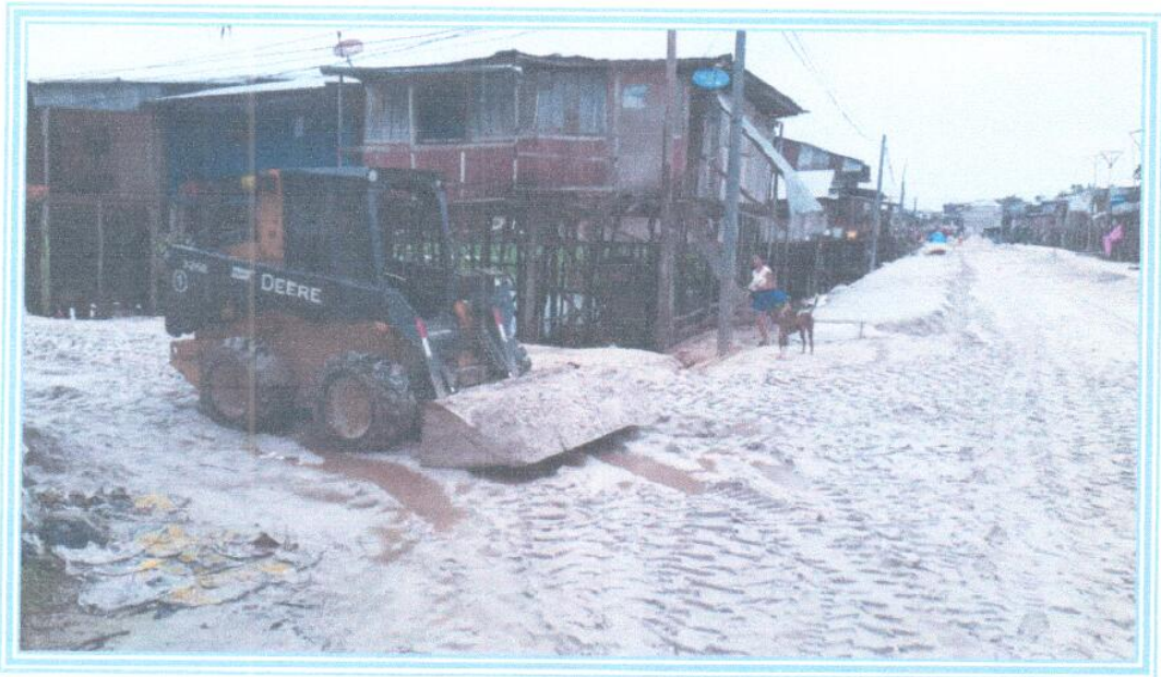
Foto 11: Se observa los trabajos de transporte de agregados por parte de la maquinaria pesada hacia los frentes de la mano obrera.
