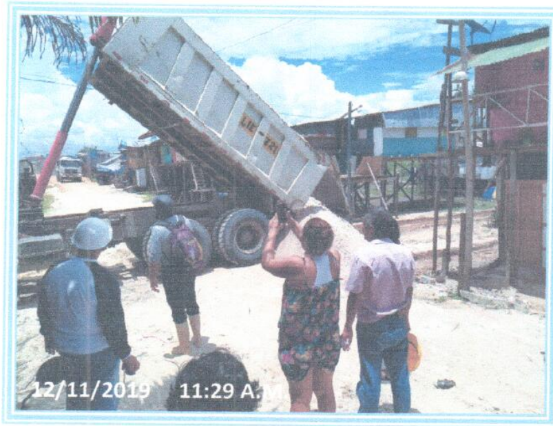
Foto 09: Se observa el abastecimiento de Material de Relleno en presencia del Residente de Obra.
