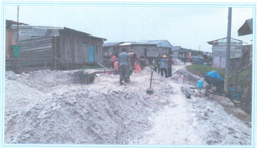
Foto 12: Se observa los trabajos de transporte manual de agregados para la preparación de la mezcla de mortero C:A 1:10.
