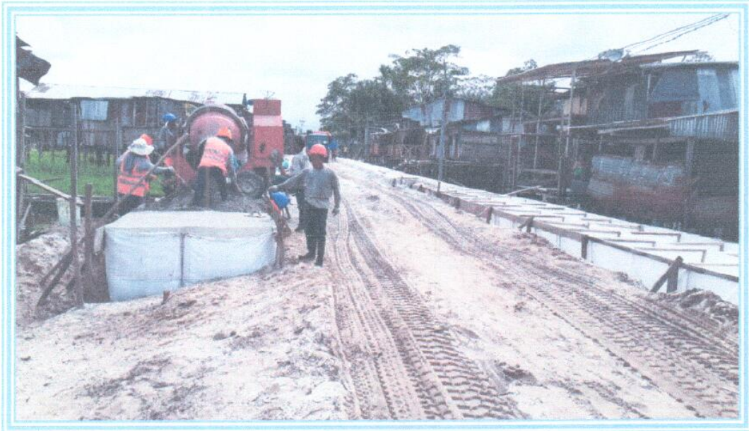
Foto 05: Se observa al personal obrero en los trabajos de vaceo de mortero C:A – 1:10 en las Big Bag para el levantamiento de rasante.
