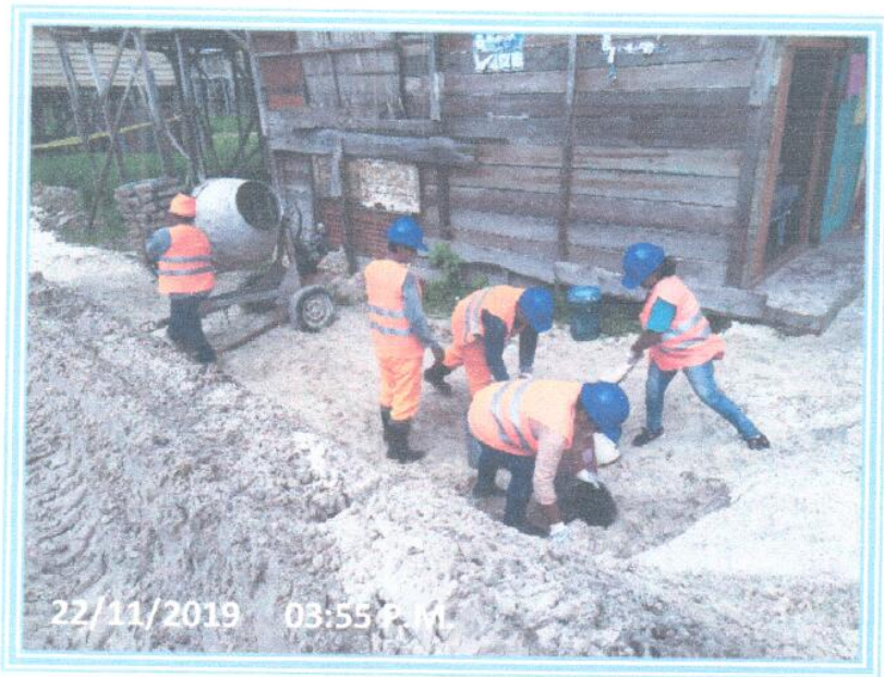
Foto 11: Se observa los trabajos de corte manual del terreno en la Obra de Glenda Freytas.
