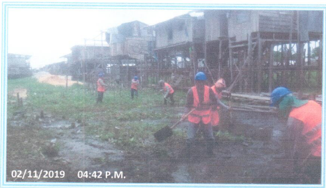
Foto 10: Se observa los trabajos de limpieza y corte manual del terreno en la Obra de Glenda Freytas.
