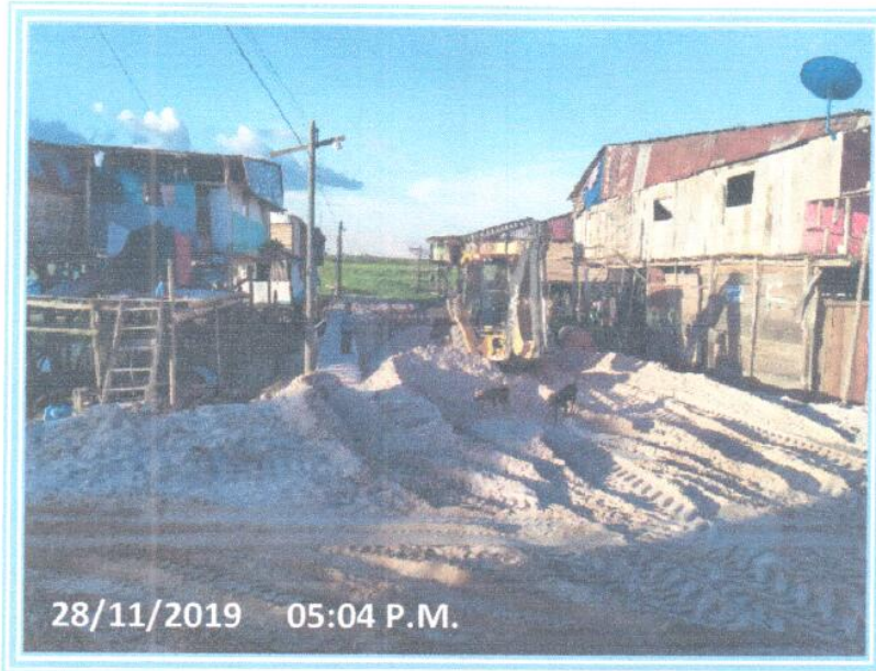
Foto 13: Se observa los trabajos de Relleno con Material de Préstamo sobre el terreno con Maquinaria Pesada sobre el terreno en la Obra de Glenda Freytas.
