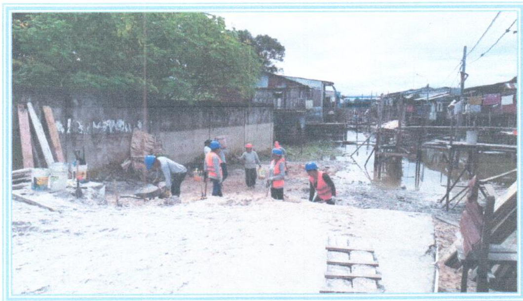
Foto 06: Se observa al personal obrero en los trabajos de corte manual.
