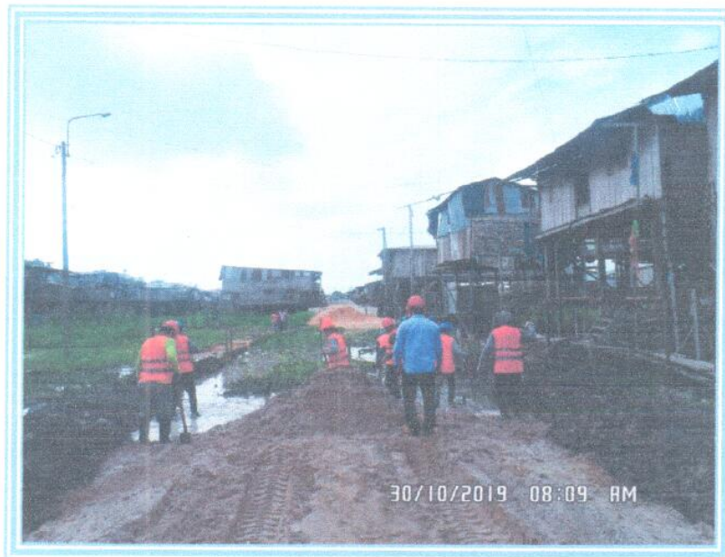
Foto 7: Se aprecia la mejora del terreno con Material de Relleno para el afirmado de las vías.
