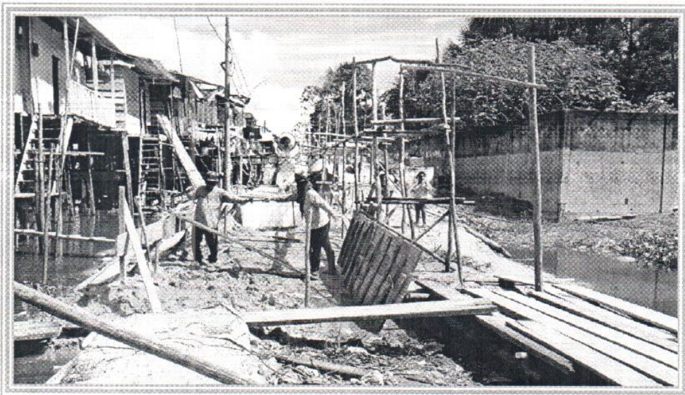
Foto 06: Se observa al personal obrero en los trabajos de limpieza, encofrado del Big Bag en la Calle Universitaria.
