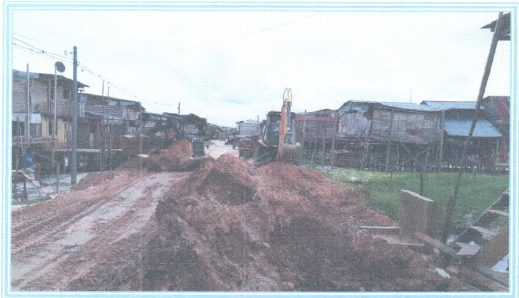
Foto 09: Se observa los trabajos de movimiento de tierra con el uso de la maquinaria pesada.
