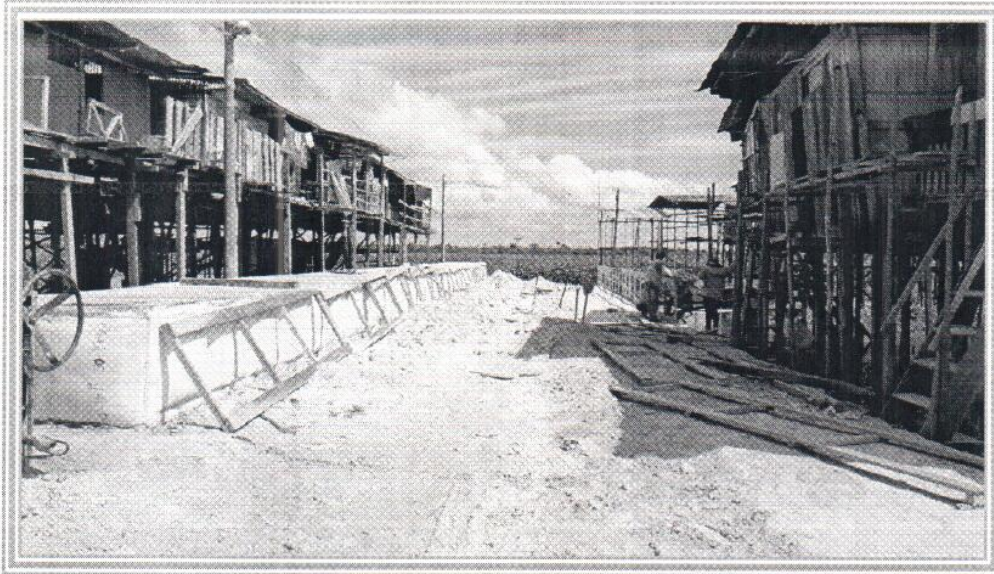
Foto 05: Se observa al personal obrero en los trabajos de encofrado del Big Bag en la Calle Universitaria.
