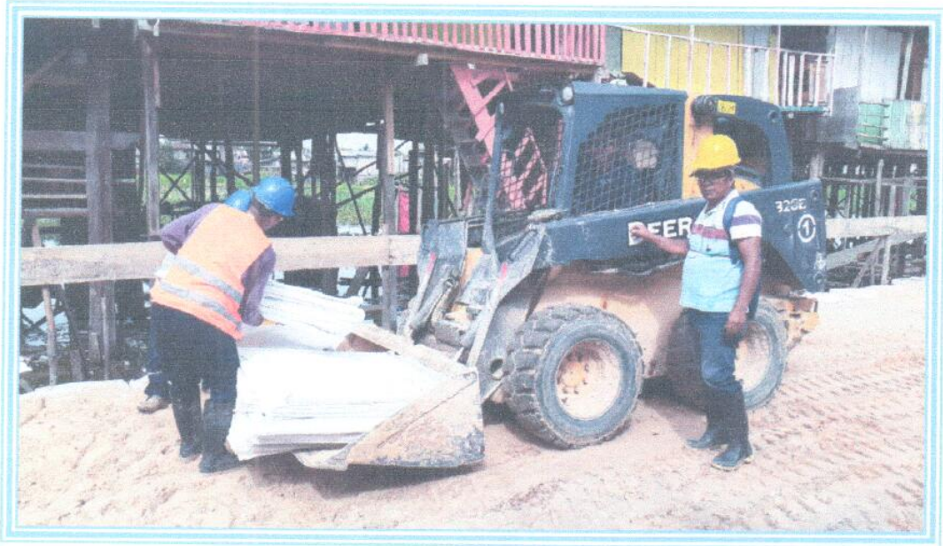
Foto 11: Se observa las actividades de traslado de Big Bag con el apoyo de la mini-cargadora bajo la dirección del Controlador de Máquinas.
