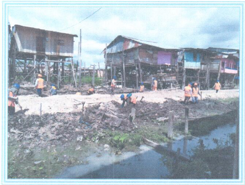
Foto 10: Se observa los trabajos de limpieza y corte manual del terreno en la Obra de Glenda Freytas.
