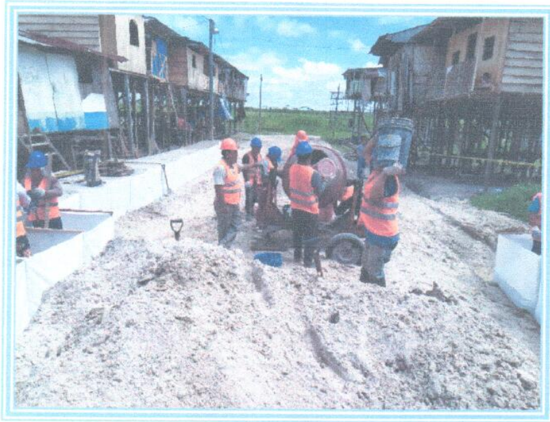
Foto 04: Se observa los trabajos de mezclado de C:A- 1:10 para la elaboración de mortero y su posterior vaceo en las bolsas Big Bag.
